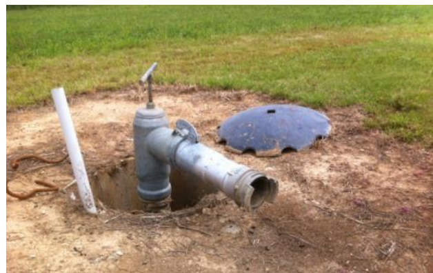
Forage avec demi-raccord de 65 mm A/R
